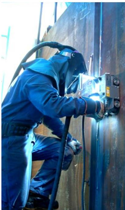
Vertikales Stoßschweißen mit Führungsschiene
